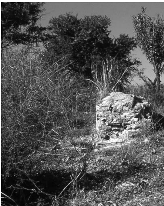
Tav. 5a - UT 98: pilastri in cementizio (portico?) lungo il perimetro meridionale della villa (da CORDIANO, ACCARDO, ISOLA, GILENTO, Herakleion akroterion , Tav. 1)
