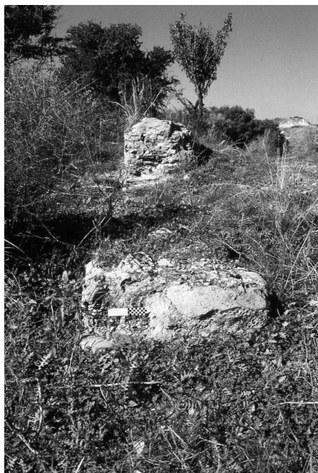
Tav 1. Loc. Stracozzara (UT 98): pilastri di un probabile portico perimetrale meridionale.
